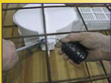
Assicurare ulteriormente la scatola ai ferri di armatura, anche legandola e facendo passare il filo metallico dai forellini appositamente predisposti a lato della scatola.
