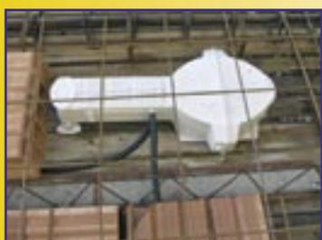
Aprire il foro di ingresso (da non dimenticare) del tubo corrugato di alimentazione ed inserire lo stesso posizionandolo in modo tale che sia ben fermo, anche legandolo ai ferri di armatura.
