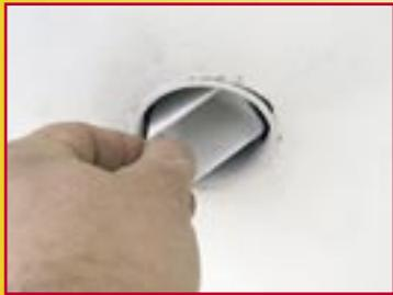
***per poi essere bloccate nel controsoffitto, incastrando dall'interno due corpi cavi destinati poi all'alloggio delle molle di ritenuta del faretto***
